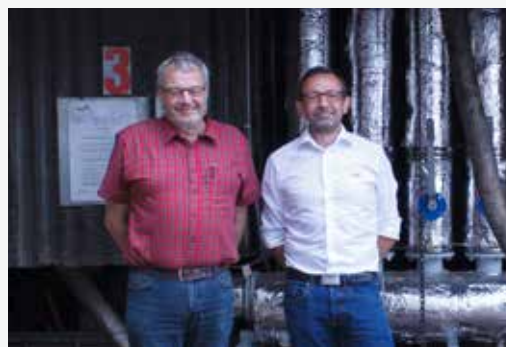
Carsten Lundhøj, NCC Maskinafdeling og Area Sales Manager Simon Anthes fra DESMI foran pumpeinstallation på NCC's anlæg i Roust
