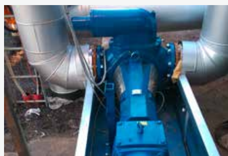
ROTAN® HD152EDDKLT-1U22S installeret på NCC's anlæg i Hjøllerup
