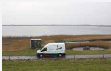
Udsigt fra dæmningen og ind mod indsøen, hvor pumpestation med frekvensomformere er placeret.
