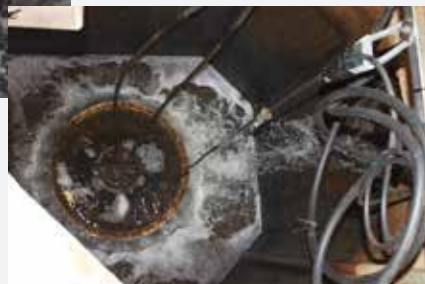
DESMI Afvandingspumpe installeret i pumpebrønd på Lumby Pumpestation. Pumpen kan klare en kapacitet på 1200 liter i sekundet.
