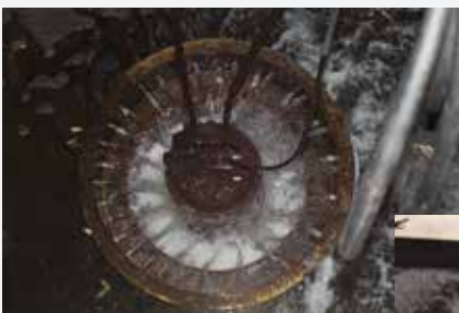
DESMI Afvandingspumpe installeret i pumpebrønd på Lumby Pumpestation. Pumpen kan klare en kapacitet på 1200 liter i sekundet.
